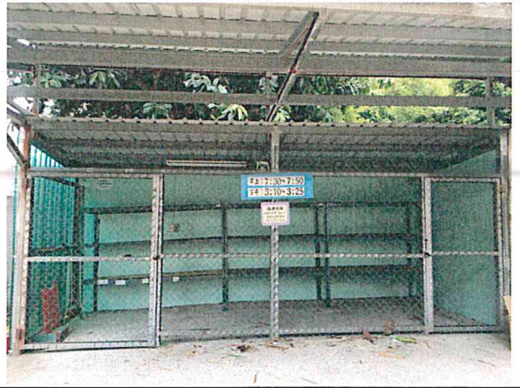
資源回收室內粉刷後牆面
