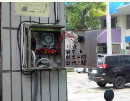
電力系統施測、施工驗收與使用說明。
