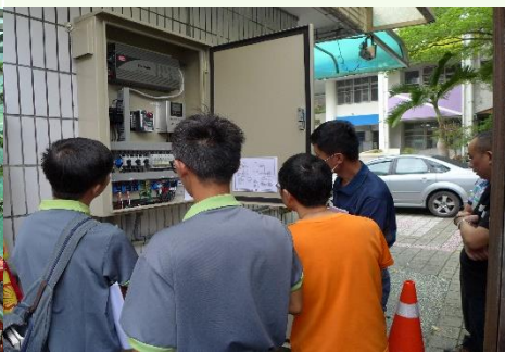
電力系統施測、施工驗收與使用說明。
