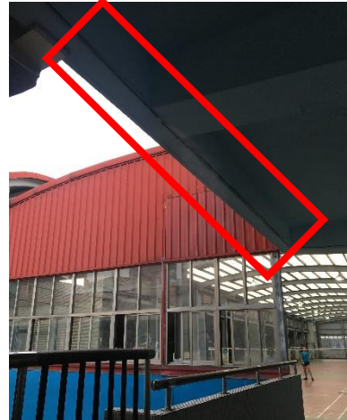
說明：灑水散熱設備，減少城市熱島效應。
