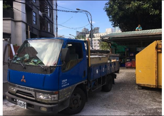
資源回收室屋頂防漏工程施工
